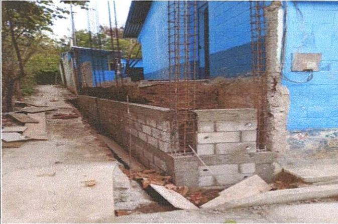
Foto1: Remozamiento de muro ya en su fase intermedia
