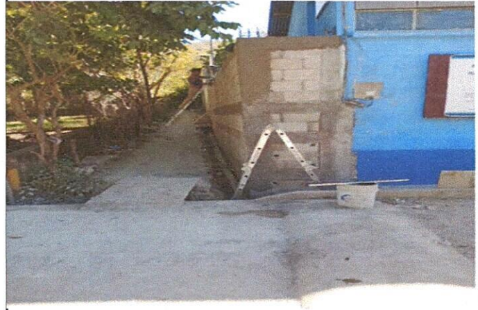
Foto 2: En esta foto, se ve el remozamiento del muro, faltando aquí la fundición de la corona final más el acabado final y la pintura.
