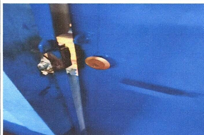
Foto 8: En esta foto se procede a la instalación de chapa de esta puerta.
